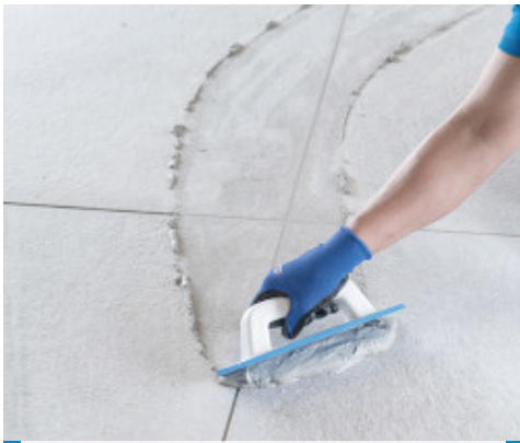
Aanbrengen van Keracolor GG met de Mapei strijkbord
