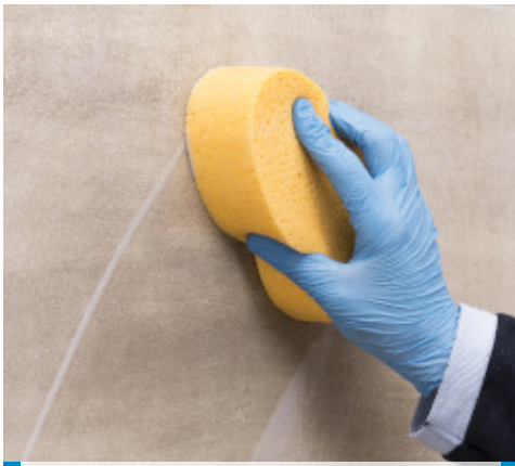
Reinigen en afwerken met een spons
