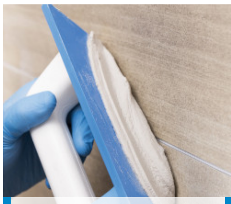
Aanbrengen van Kerapoxy 4 LVT met een rubber spaan
