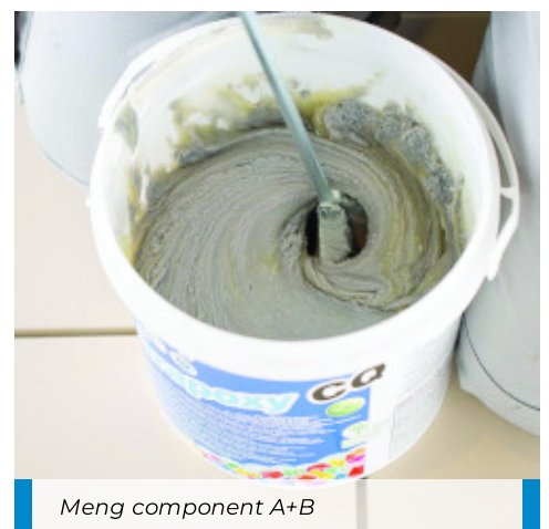
Giet de verharder (component B) in de emmer met component A
