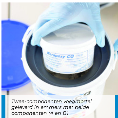
Giet de verharder (component B) in de emmer met component A
