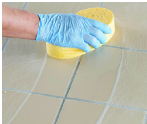
Reinigen en afwerken van voegen met een harde cellulose spons
