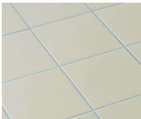
Eindresultaat van een vloer gevoegd met Kerapoxy CQ
