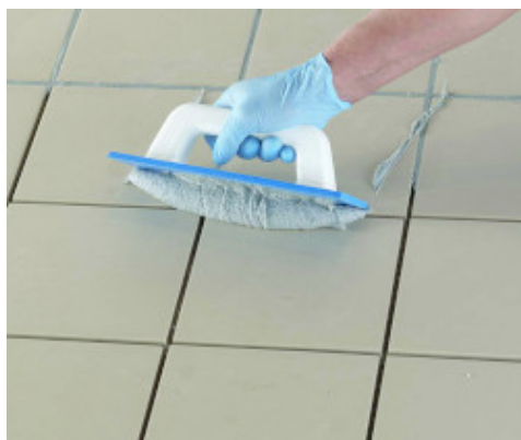
Aanbrengen van Kerapoxy CQ met de Mapei rubber voegbord
