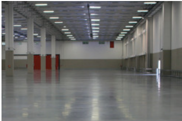
Voorbeeld van een industriële betonvloer waarin Mapefibre NS18 is toegepast
