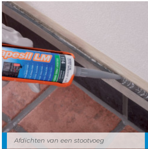
Afdichten van een gevelvoeg met Mapefil LM
